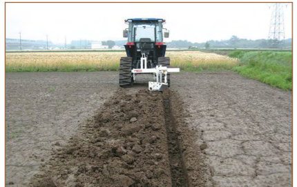
明渠施工で降雨による表面水をすばやく排水
