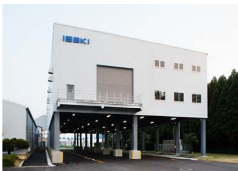
完成した新塗装棟
